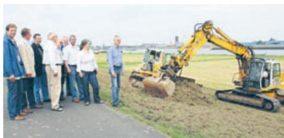
Bis Oktober, also dem Beginn der sogenannten Sturmflutsaison, rollen in Seehausen am Deich die Bagger. Der Hochwasserschutz wird auf einer Länge von 1,5 Kilometern um bis zu 70 Zentimeter erhöht. FOTO: GERBRACHT
